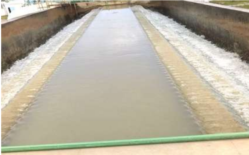
Photo n°04 : Cascade d'aération (©Amraoui et Ogab ,2022)
