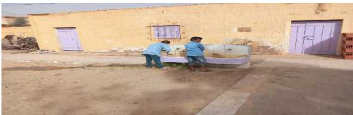
Photo n° 05: Lave mains non alimenté en eau courante. (Mezouar, 2017)
