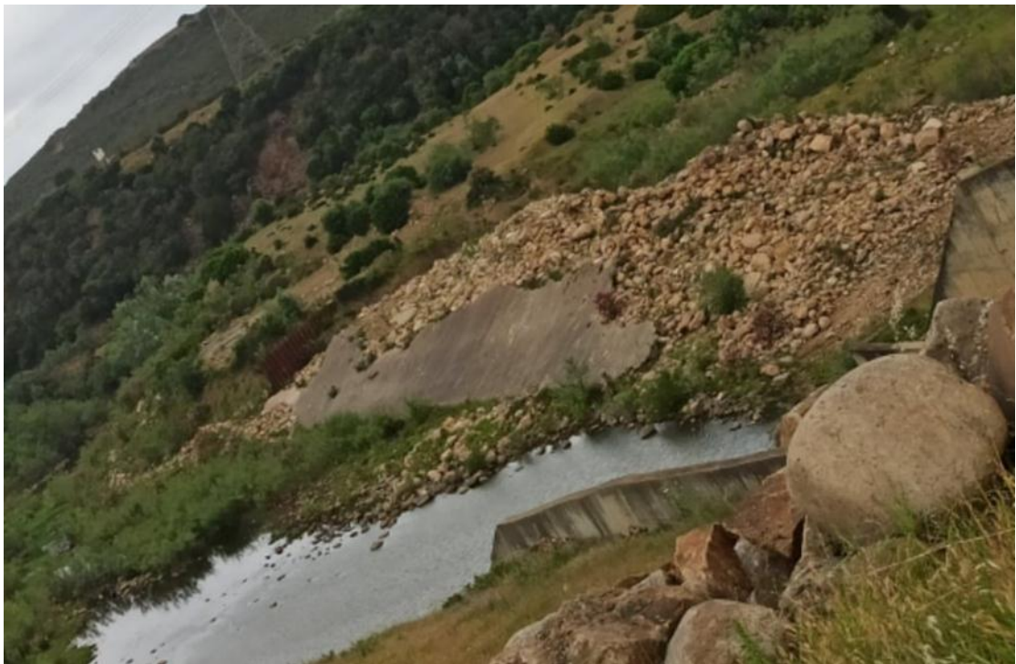
Photo 8. Vue générale du barrage Mexa ( photo original ).
