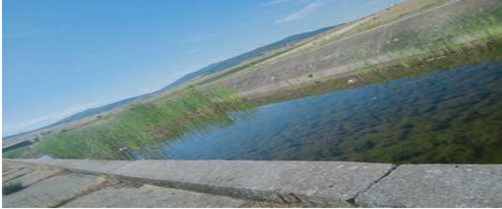
Photo 7. Vue générale de la digue du barrage Chafia ( photo original ).
