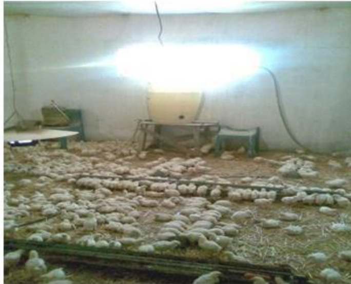
Photo 13 : Installation d'eau à l'intérieur du bâtiment
