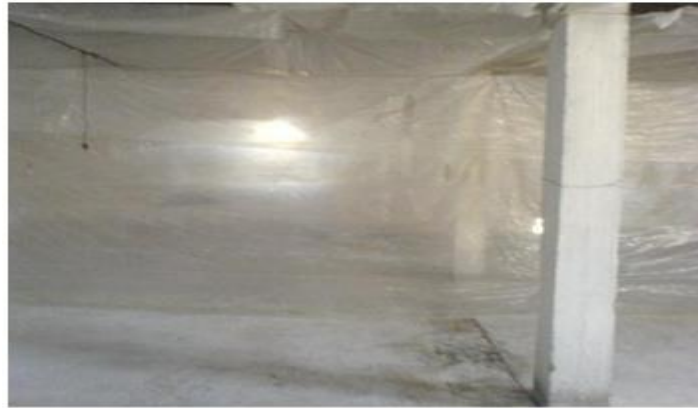
Photo 16: 1ère isolation et faux plafond en plastique.
