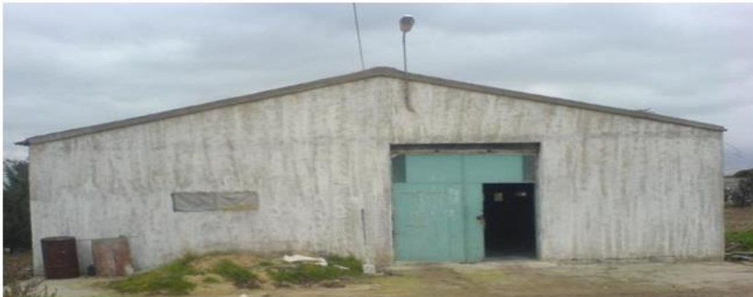
Photo 5 : Façade nord du bâtiment
