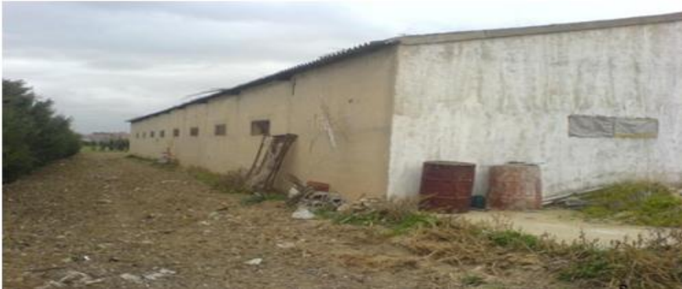
Photo 4 : Coté Est du bâtiment avec ses 8 fenêtres
