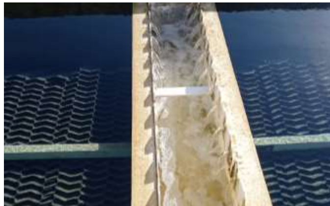
Figure III.5 : Lits de décantation lamellaire.
