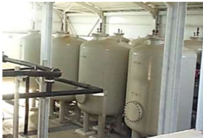
Figure III.6 : Filtre sur sable.
