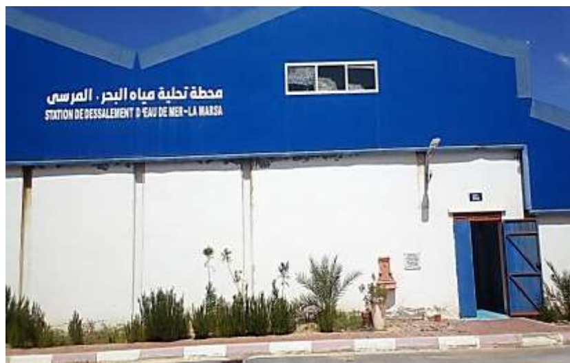
Figure III.1 : Vue d'enter de la station de dessalement d'eau de mer – La Marsa.
