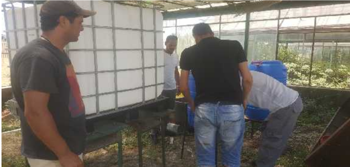
Figure 35 : Montage des filtres biologique et à tourbillon.
