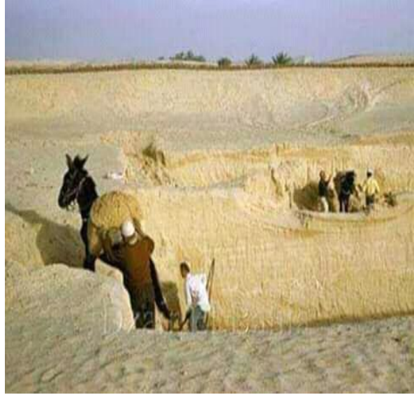
طريقة رفع الرمل لإنشاء غوط
