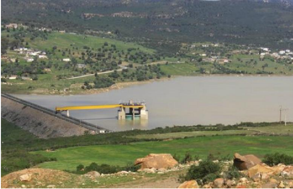
Photo 03. Barrage de Cheffia
