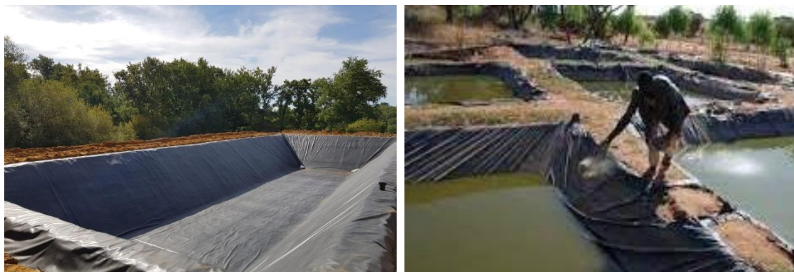
Figure 6.b : Bassins en terre étanchés par un film plastique ( https://www.shutterstock.com/fr ).
