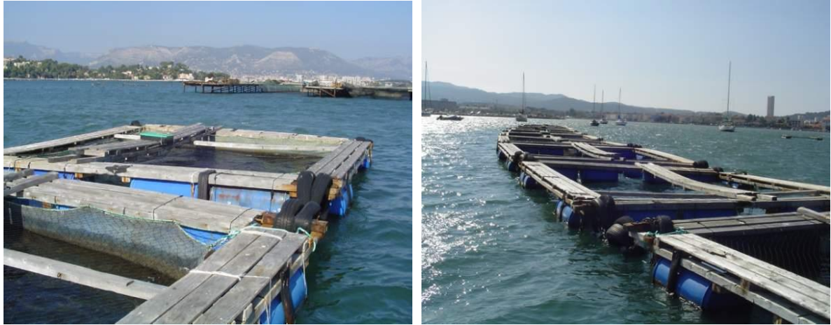
Figure 10. Structure de flottaison exposée au biofouling.
