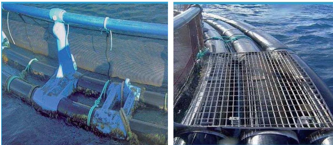
Figure 7. Image d'un ponton d'une cage flottante à deux et trois anneaux.
