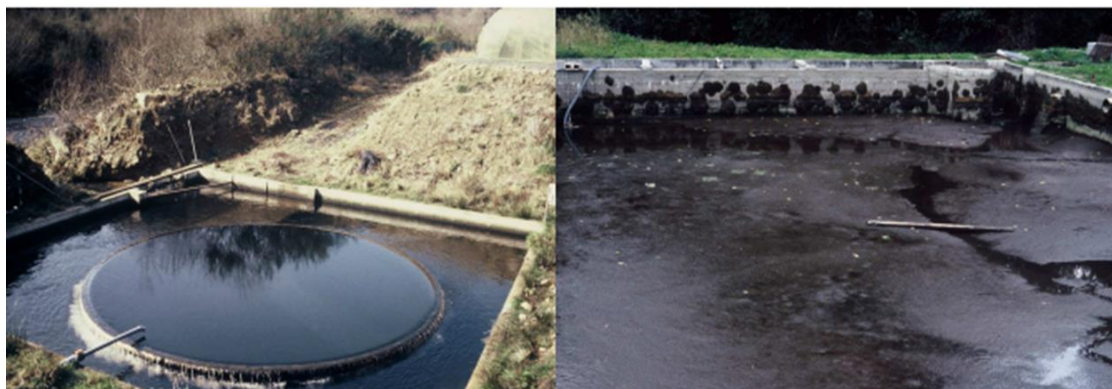
Figure 14.b : décanteur circulaire et à plat (Ifremer Palavas - G. Lemarié 2009).
