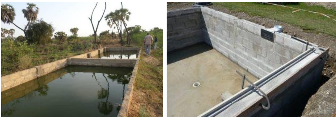
Figure 8 : Bassin avec des parois réalisées en parpaings ( https://www.shutterstock.com/fr ).
