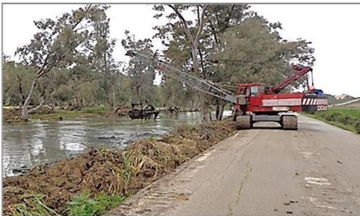
Photo 16. Opération de curage du canal Messida (18/04/2013)
