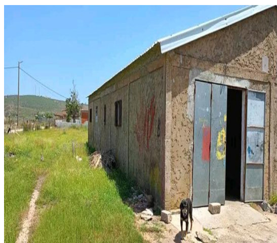
Figure 25. Bâtiment d'élevage d'une Exploitation enquêtée
