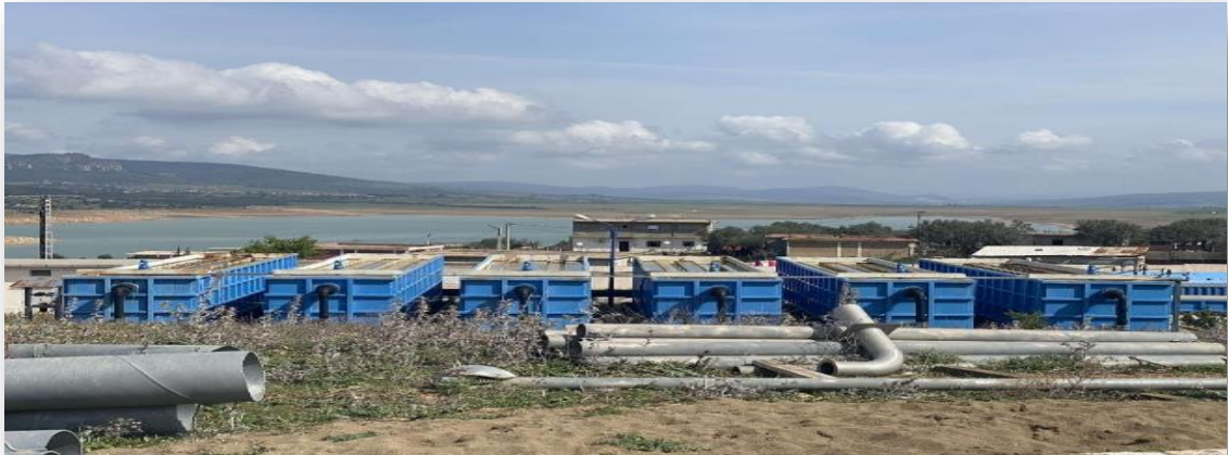
Figure N°06: Station de traitement des eaux (CHAIBA)
