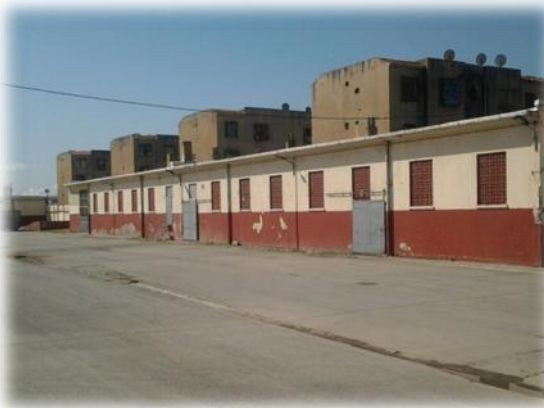
Fig.5 : Bâtiment d'abattage de volaille vue extérieur. Photo personnel (Boulahbel.A. 2017)
