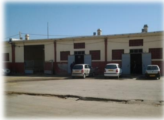
Fig.7 : Bâtiment de nettoyage des abats Photo personnel (Boulahbel.A.2017)
