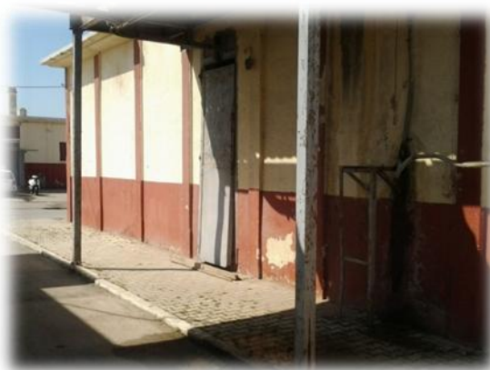
Fig.9 : Chambre froide Photo personnel (Boulahbel.A.2017)
