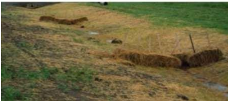
Figure 23 : Image de technique des ballots de paille contre l'érosion. (RAPPEL, 2003)
