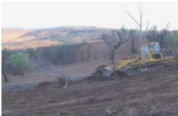
Figure 15 : Image de Dessouchage au riper.
