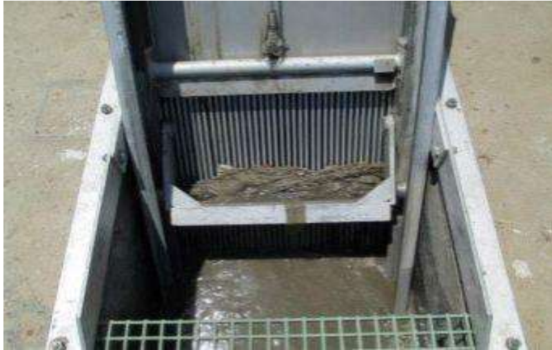
Figure 2 : Dégrilleur manuel à grille oblique*[14]
