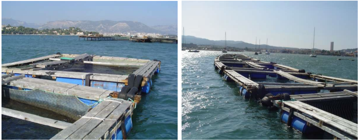
Figure 10. Structure de flottaison exposée au biofouling.
