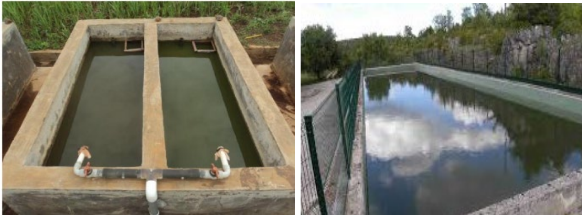
Figure 7 : Bassin en béton ( https://www.shutterstock.com/fr ).
