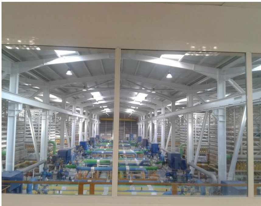
Figure 16:L'étape de l'osmose inverse [59]
