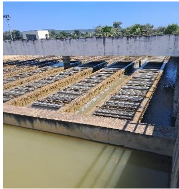
Figure 7: Bassin de décantation (Photo Hendi Fathi 2026)
