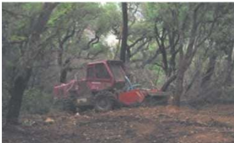
Figure 12 : image des travaux de broyage de la végétation basse.
