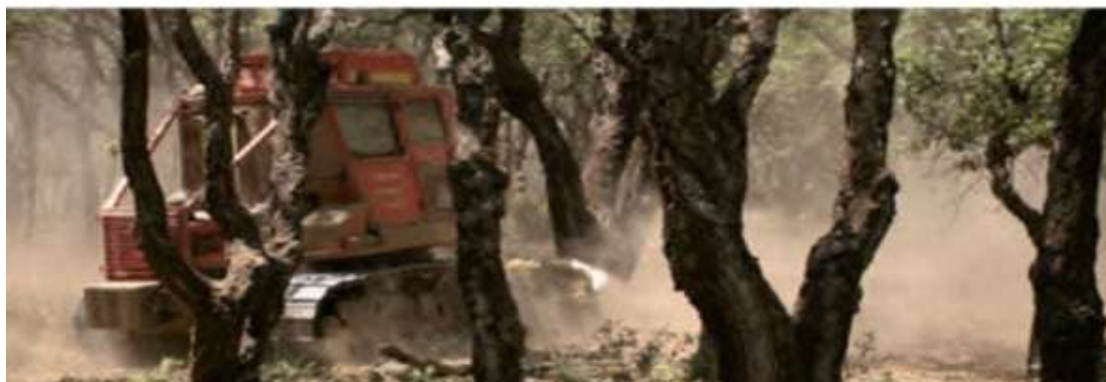
Figur13. Image des travaux du broyeur d'entretien.
