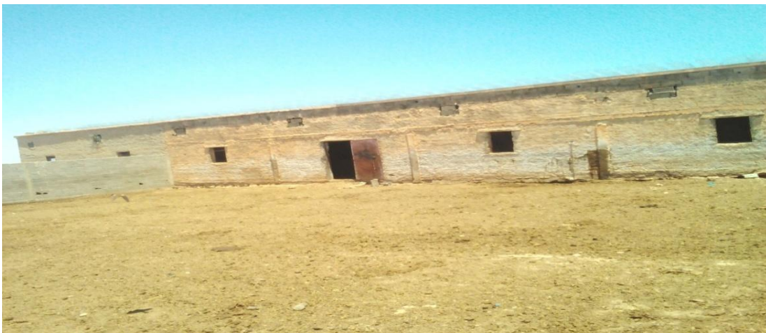
Photo personnelle 1 : Présentation du bâtiment d'élevage de la zone d'étude 2de la wilaya de Sétif
