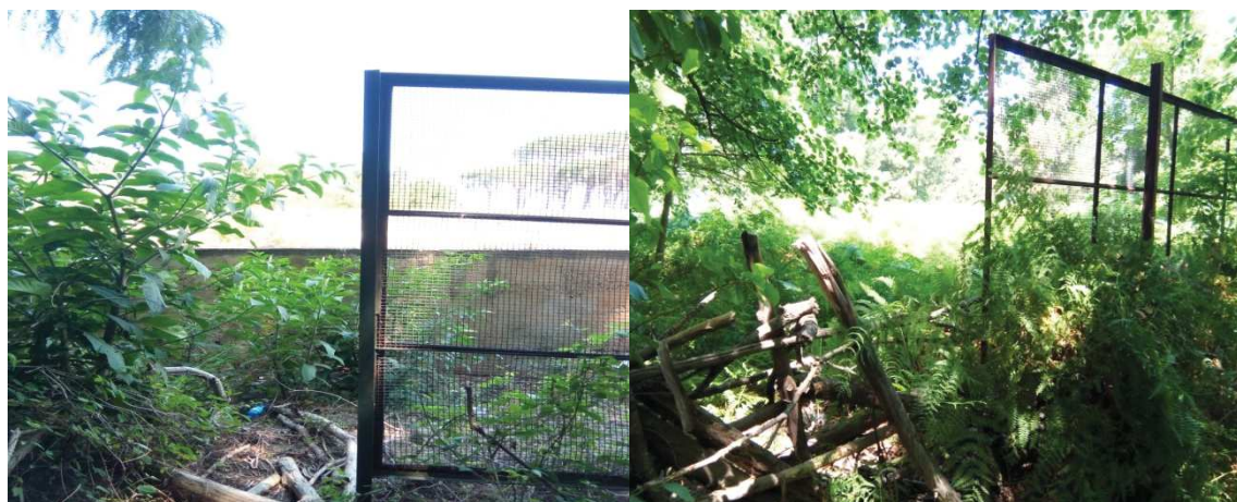
Figure 11. À gauche : clôture galvanisée discontinue ; à droite : prolongement de la clôture galvanisée avec une clôture artisanale.
