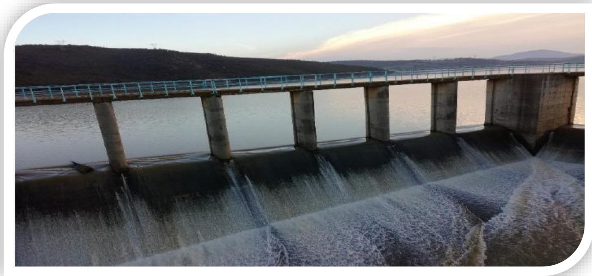
Figure n° 8. Barrage Mexa (Direction du barrage, 2020).
