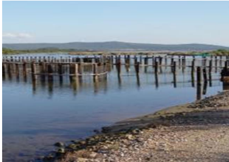
Figure 14. Bordigue du lac El Mellah (Ramasar, 2022)
