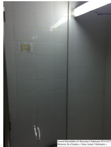
Figure N°12 : Les murs en faïence
