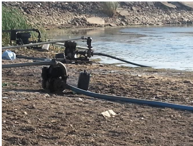
Figure 10. Le pompage d'eau de la retenue collinaire de Tiffech (Photo GUELLATI.K 28/06/2013)
