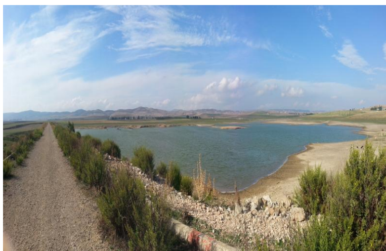
Figure 4. Vue générale de La retenue collinaire de Tiffech (Photo GUELLATI.K 18/09/2013)
