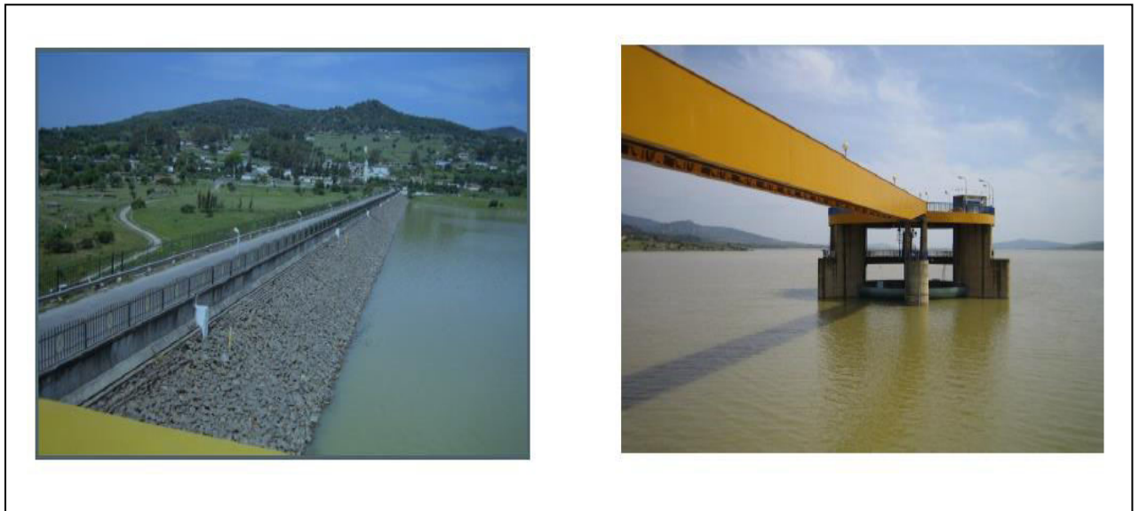
Figure09. Barrage vue générale Chaffia.
