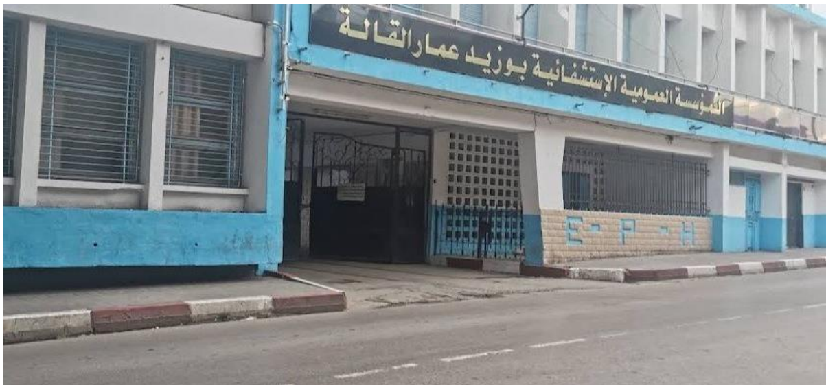
Figure02: Hôpital Bouzid Ammar –El Kala - .
