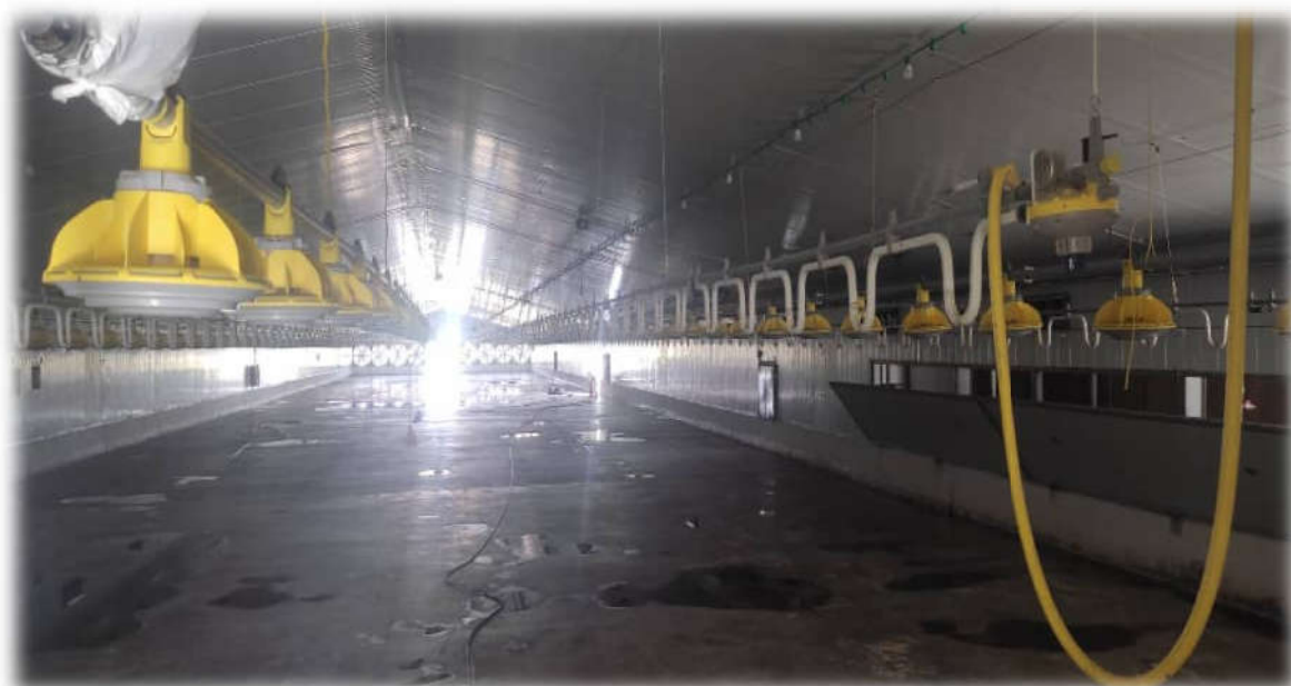
Figure 14 : Désinfection et nettoyage du bâtiment et des équipements (Arioua, 2023)
