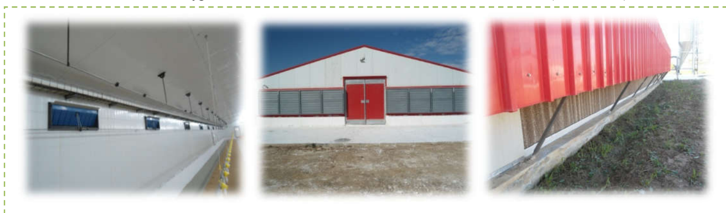
Figure 16 : Système de ventilation (Trappes, Ventilateurs géants, Pad-cooling (Arioua, 2023)
