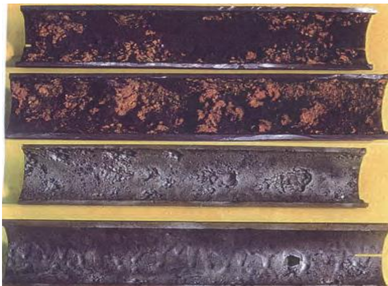
Figure N°10 : Corrosion de l'intérieur (attaques mixtes groupées, autant sur la partie supérieure, qu'inférieure)
