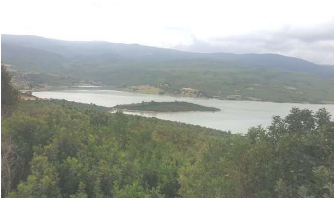
Photo 15. Barrage de Mjouda (Gheldane R., 2022)
