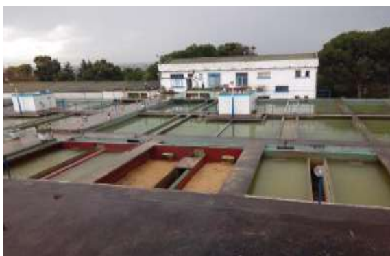
Photo.III.1 : Station de traitement des eaux « Chaiba » [1].
