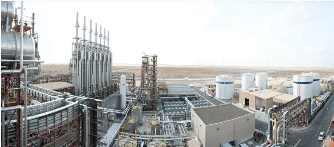
الشكل رقم (3-9): محطة الطاقة الشمسية المركزة شمس
